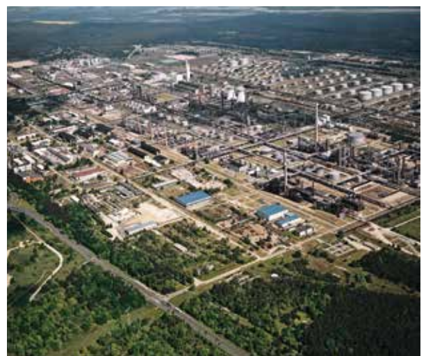
Gelände der PCK Raffinerie GmbH
