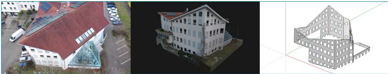
Abbildung 3: Die Zusammenarbeit von Mensch, Drohnen und KI-Methoden zur Vermessung von Gebäuden (Quelle: Airteam Aerial Intelligence GmbH)
